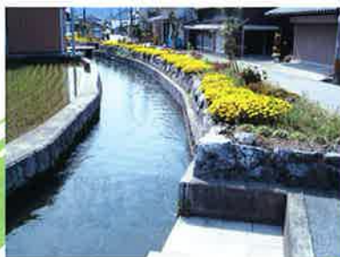
きれいに植栽された水路沿いの様子
