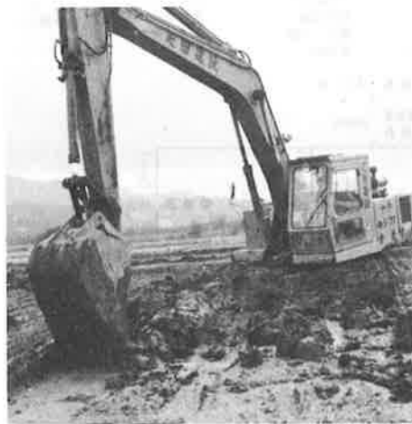
道路新設に伴うはぎ取り工事
