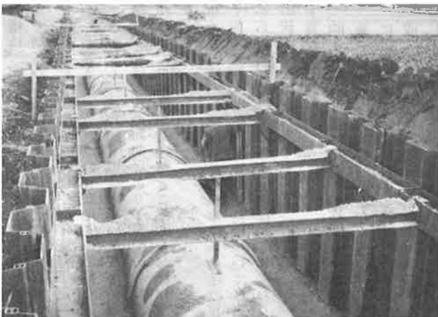
送水管埋設工事
