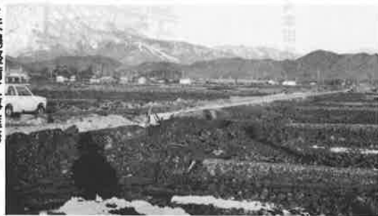
▶ほ場整備工事進む 長沢第二工区
