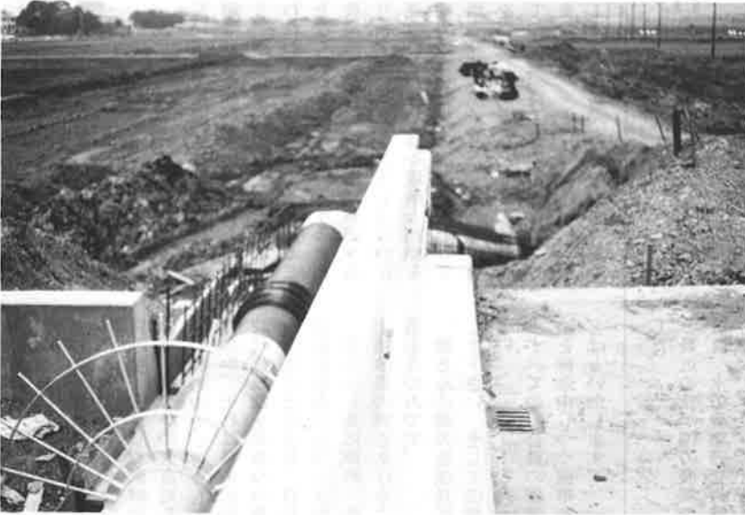
▲落合橋を渡り長沢工区へ
