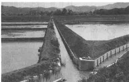
世継工区より飯工区を望む
