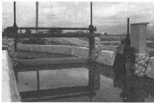
完成した循環かんがいゲート
