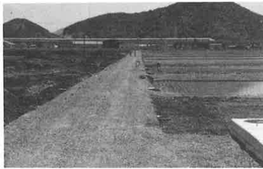
▶一部完成の上多良工区
