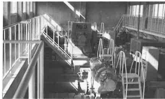
▶ 3号機据付け完了
