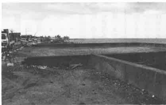
撤去・整地された跡地
