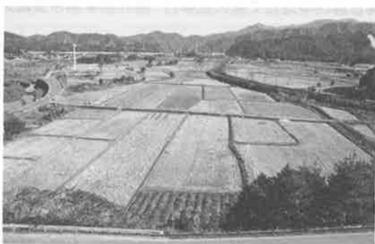
蒲原工区の現況
