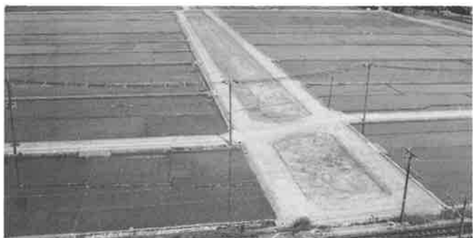
完成した飯第三工区▶ (北陸線東)中央は都計道路用地
