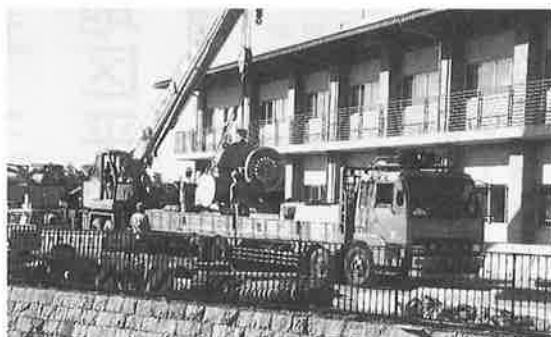
▶ 12月13日 新ポンプ搬入
