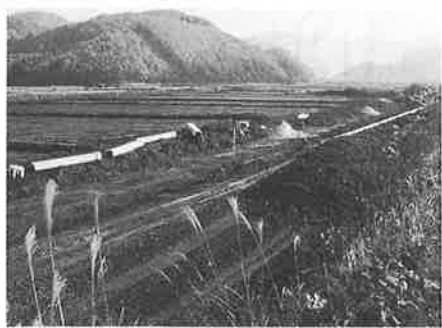
天の川提防より 能登瀬工区を望む
