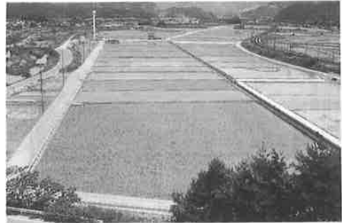
▶完成した蒲原工区
