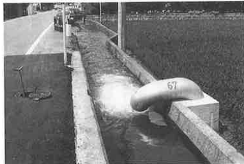
▶完成した6号分水関係 舟崎幹線吐出し
