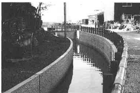
完成した世継新川と町道
