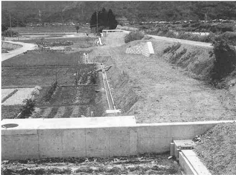
▲ 能登瀬地先 中央幹線パイプ埋設地
