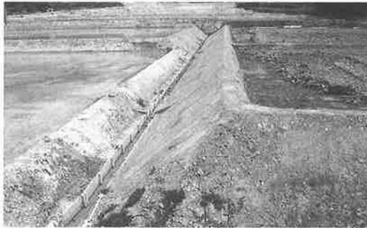
▼ 工事中の日光寺西谷
