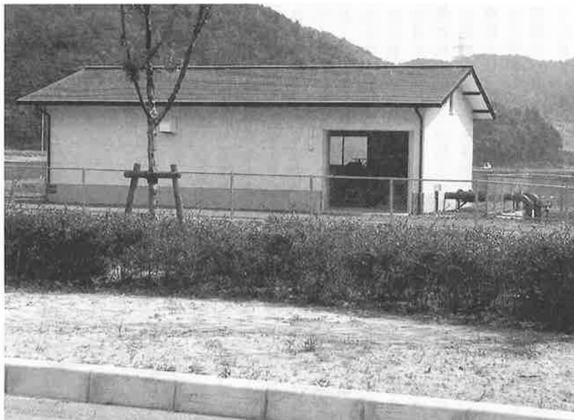
▲ 新築の番場揚水機場
