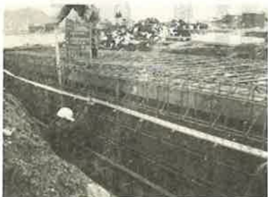
幹線道路暗渠工事横断排水路 鉄筋検査
