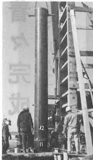
さく井を終え 径600mmの鋼管を122m熔接し挿入する井戸工事
