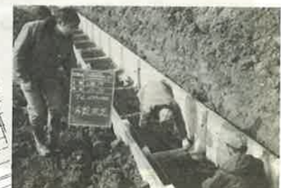
排水路工事 アーム布設点検作業
