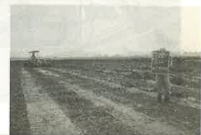
整地工事 表土均作業
