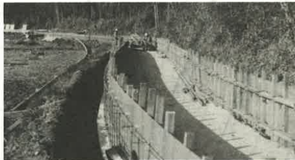
鉄筋も組み終り型枠組立工事中の右岸幹線水路
