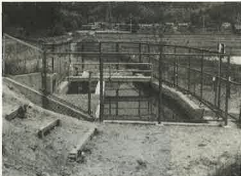
完成した沈砂池工
