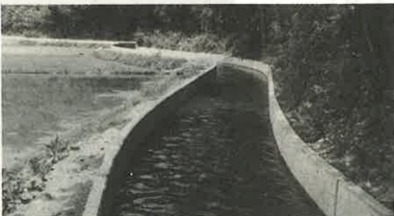
見事完成した右岸幹線水路
