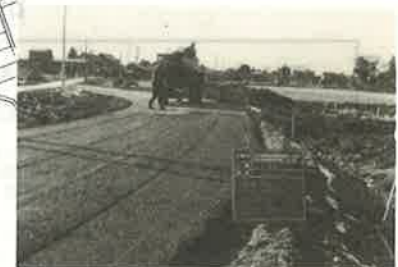
町道横断暗渠のための迂回路工事
