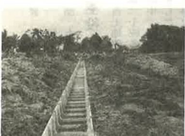
工区西端の排水路・整地工事
