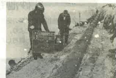
かん排・南幹線送水路工事 転圧作業
