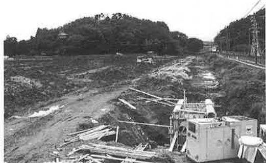
▶ 工事進む岩脇工区JR沿い
