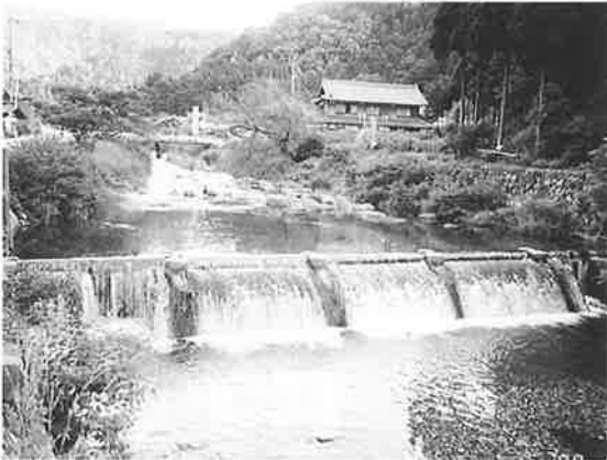
丹生川合同井堰（改修前）
