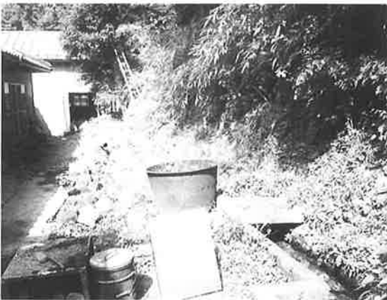
丹生川右岸幹線水路（改修前）
