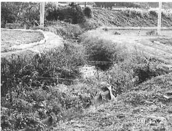
天の川左岸幹線水路（改修前）
