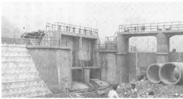
合同井堰の取水樋門・排砂樋門完成 (S 30.11)
