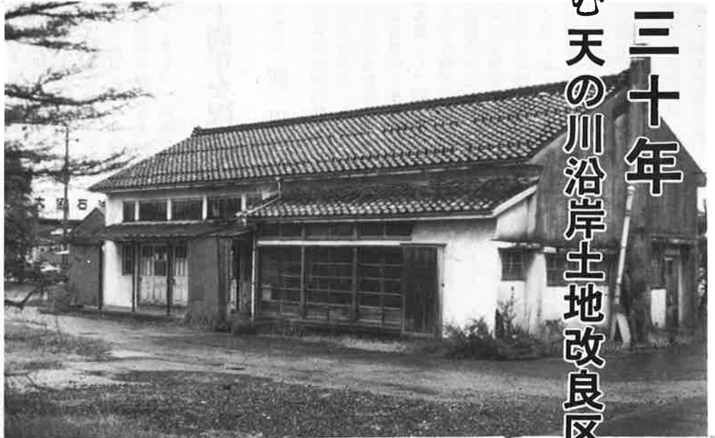
つわものどもの夢のあと 今はなき旧事務所(S 59.9.10 解体前に写す)
