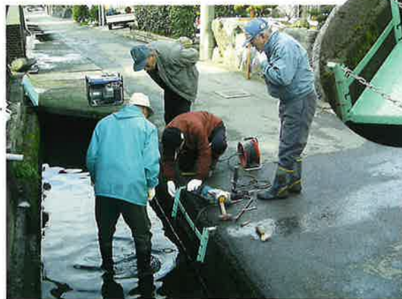
上多良洗い場設置作業
