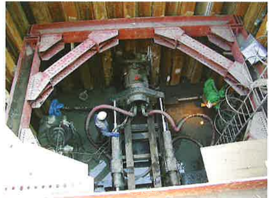
長沢地区土川横断水路工事
