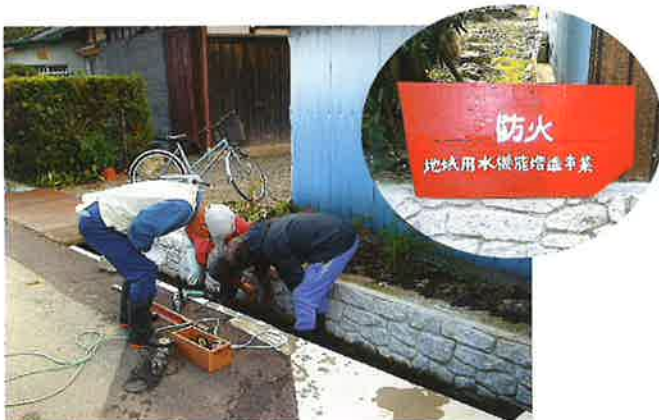
飯地区防火用堰板アングル取付作業
