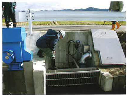
宇賀野地区反復ポンプ設置
