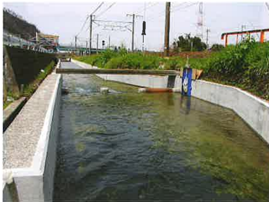
樋口地区左岸幹線水路補修
