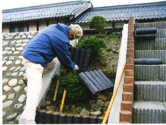
上多良地区親水性分水工植栽作業
