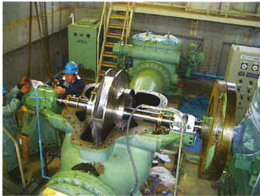
天の川揚水機場ポンプ改良更新
