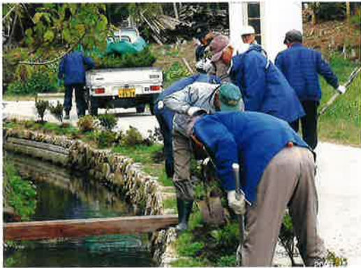
能登瀬地区植栽作業
