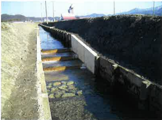
世継地区排水路整備
