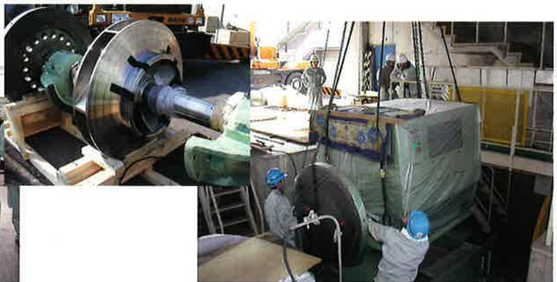
天の川揚水機場モーター整備
