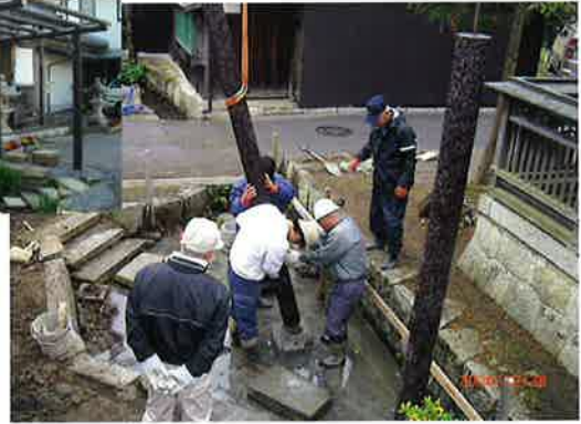
上多良地区藤棚設置作業
