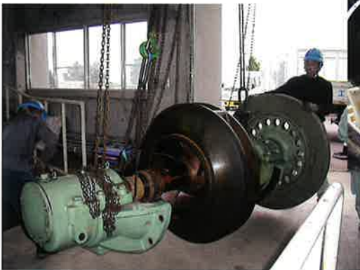
天の川揚水機場ポンプ整備
