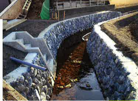
中多良地区 景観に配慮した排水路の改修
