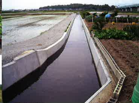
舟崎地区 支線用水路改修
