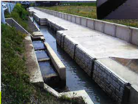
上多良地区排水路改修 地元要望による魚に配慮した流末階段工
