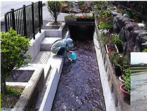
顔戸地区支線用水路改修 洗い場を利用
