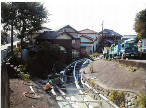
岩脇地区左岸幹線水路改修
