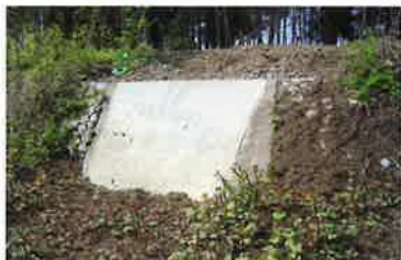
天野川旧井堰取水口閉塞工事
