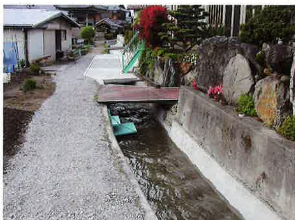
顔戸地区高満線水路改修
