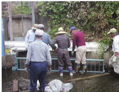
飯地区スクリーン設置作業
