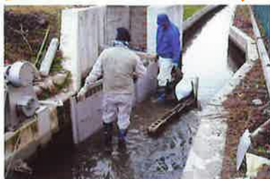
ごみ避け仕切板の設置作業
