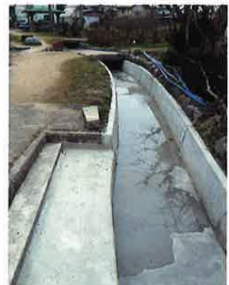
箕浦地区用水路工事完了状況
