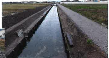
寺川排水路工事完了状況
