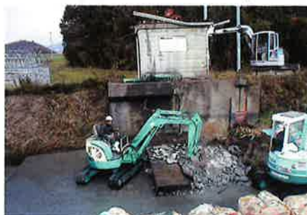
土川下井井堰撤去状況
