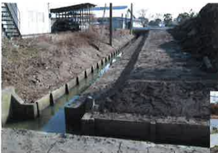
宇賀野排水路工事完了状況
