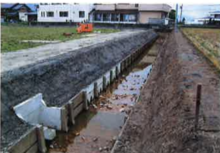
筑摩地区排水路工事完了状況
