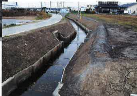
顔戸排水路工事完了状況
