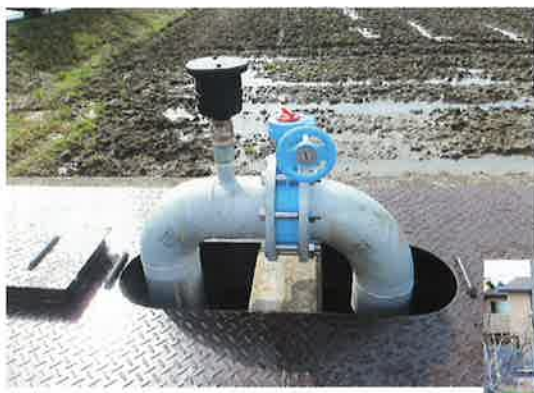
送水管吐出口改良
