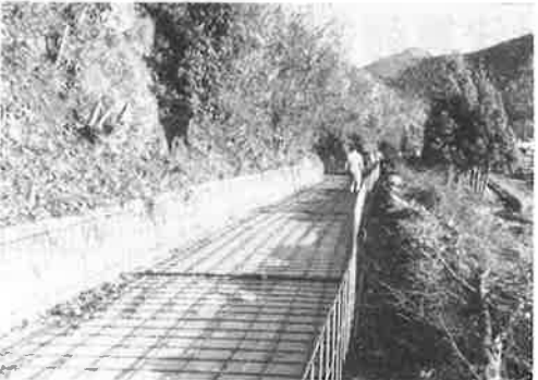
③ 鉄筋組立
