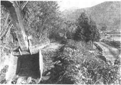
② 旧水路コンクリート取こわし
