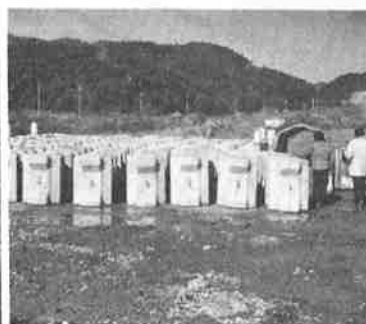
天の川合同地区 2トン型護床ブロック製作風景
