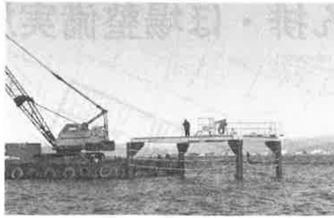
取水施設工事 湖水の呑み口はこの下
