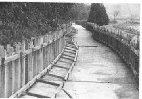
④ 立上り型枠組立
