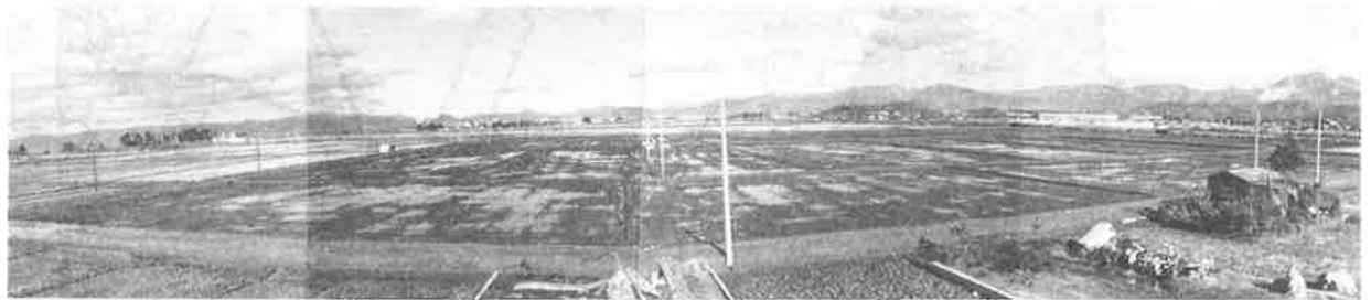
天の川西部地区 完成した宇賀野第三工区工事夏季施工（木村春造氏の屋根上より写す）
