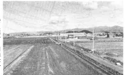
天の川西部 宇賀野第三工区工事冬期施工準幹線道路（学童道）深い、20号支排附近（川崎伝蔵氏の屋根上より写す）
