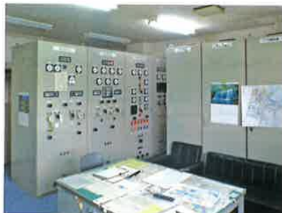
天の川揚水機場操作室
