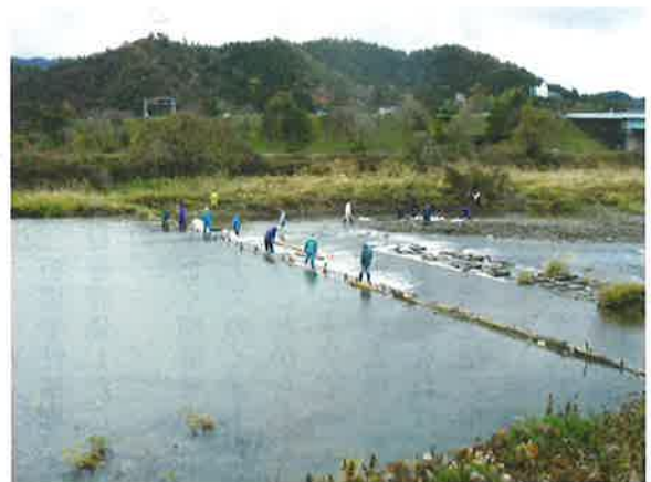
地元による井堰補修の様子
