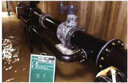
分水工バルブ ↓ 取替前(上) 取替後(下)
