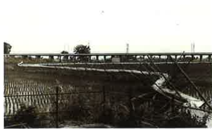
トタンをつないだ掛樋の水路で上流へ送水
