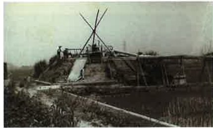
旧琵琶湖逆水の吐出口から掛樋をつなげる
