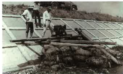
パーチカルポンプによる応急対策
