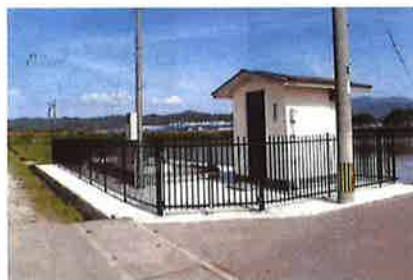
第1分水路 完了
