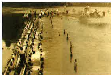
大応寺井堰(昭和28年頃、箕浦地先)
