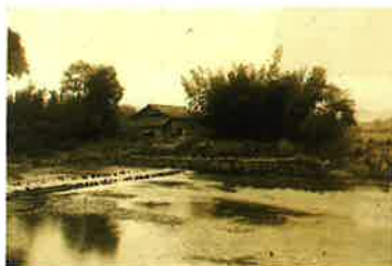
卸代井堰(昭和29年頃、飯地先)
