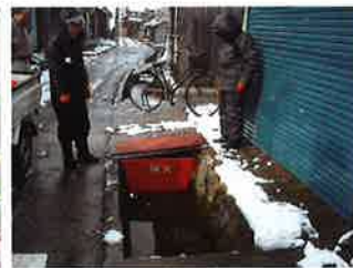
各集落による防火用堰板設置
