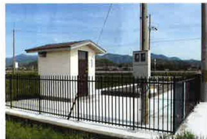
第3分水路 完了
