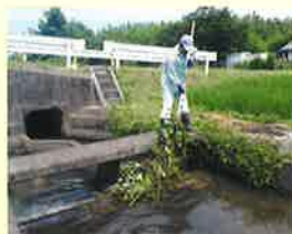
上多良地区上多良分水工作業
