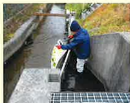
長沢地区土川サイフォン作業
