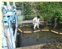
飯地区小山樋門作業
