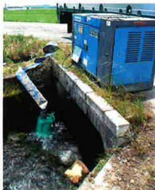
大型発電機と水中ポンプの設置
