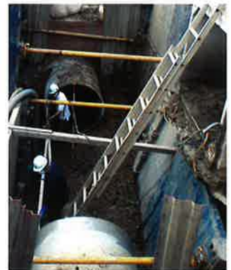
切断後ズレの幅等を確認
