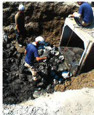
排水路ボックス撤去後
