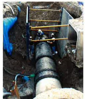
接続することができたためボルトを締める
