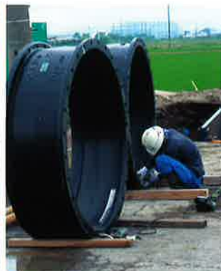
規格の違いやズレに対応するため铸铁管のリングを削っている様子
