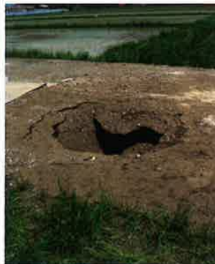
漏水箇所の陥没
