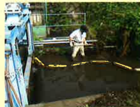
飯地区小山樋門作業
