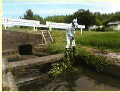
上多良地区上多良分水作業
