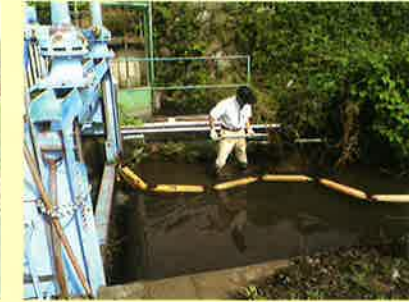
飯地区小山樋門作業
