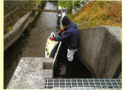
長沢地区土川サイフォン作業
