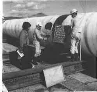
かん排導水管工事(直径1.6m)
