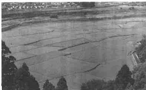
能登瀬工区従前地
