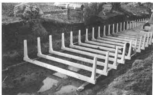
世継工区排水路工事
