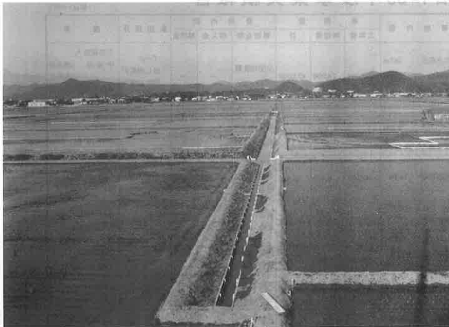
朝妻筑摩工区 10号支線排水路
