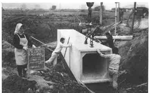
筑摩地先ボックス工事
