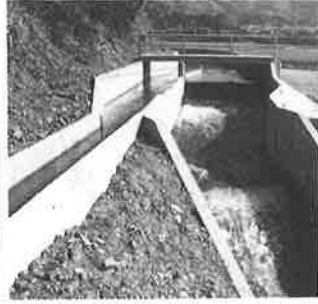
天の川右岸幹線水路竣工
