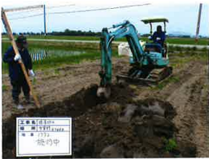
① 暗渠排水工事
