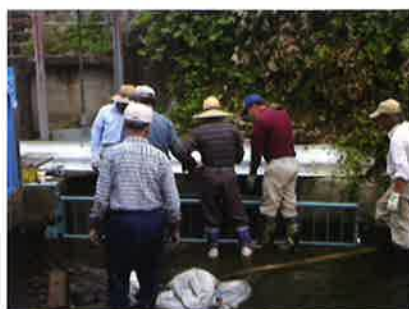
ごみ撤去作業に配慮したスクリーンの設置作業
