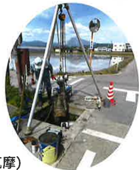
④ポンプ清掃作業(宇賀野)
