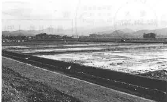
天の川西部地区 ほ場整備施工中
