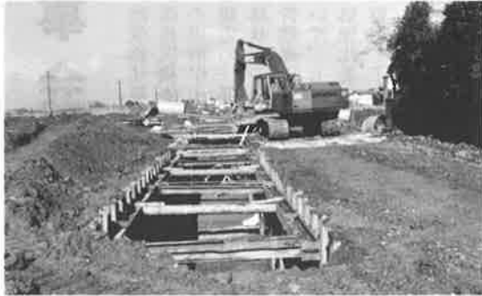
送水管埋設工事 (宇賀野工区付近)
