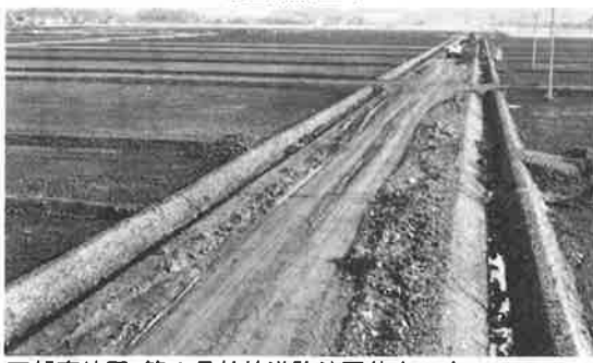
西部南地区 第1号幹線道路路面仕上げ工事
