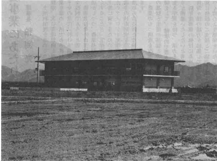
揚水施設整備事業建家(ポンプ場)
