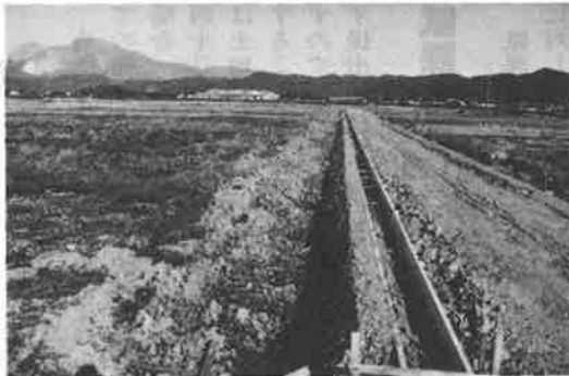
▶面工事進む 長沢工区湖岸寄り
