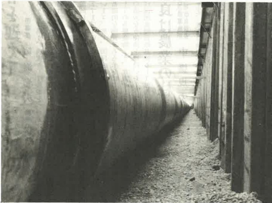
▲世継工区の700ミリパイプ埋設状況
