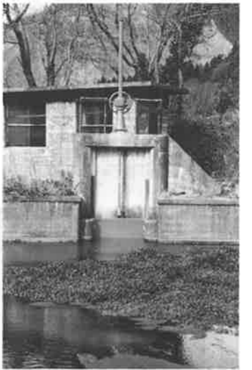
▲ 天の川合同排砂樋門
