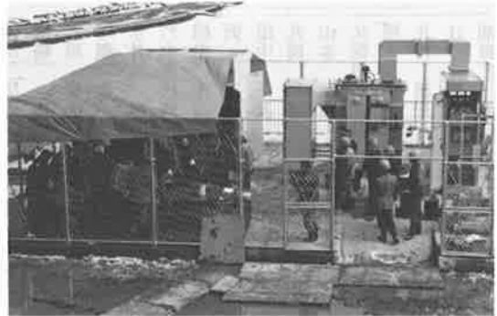
大阪通産局受電検査
